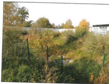
Naturnah angelegtes Retentionsbecken im Nordosten des Plangebiets.
