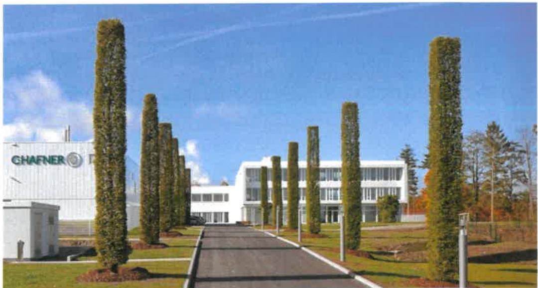
Abbildung 7: Realisierte Bebauung Fa. C. Hafner, Plangebiet von Osten / Zufahrt Maybachstraße, 10/2015 (Quelle: Fa. C. Hafner, google earth, zugegriffen am 14.09.2022)
