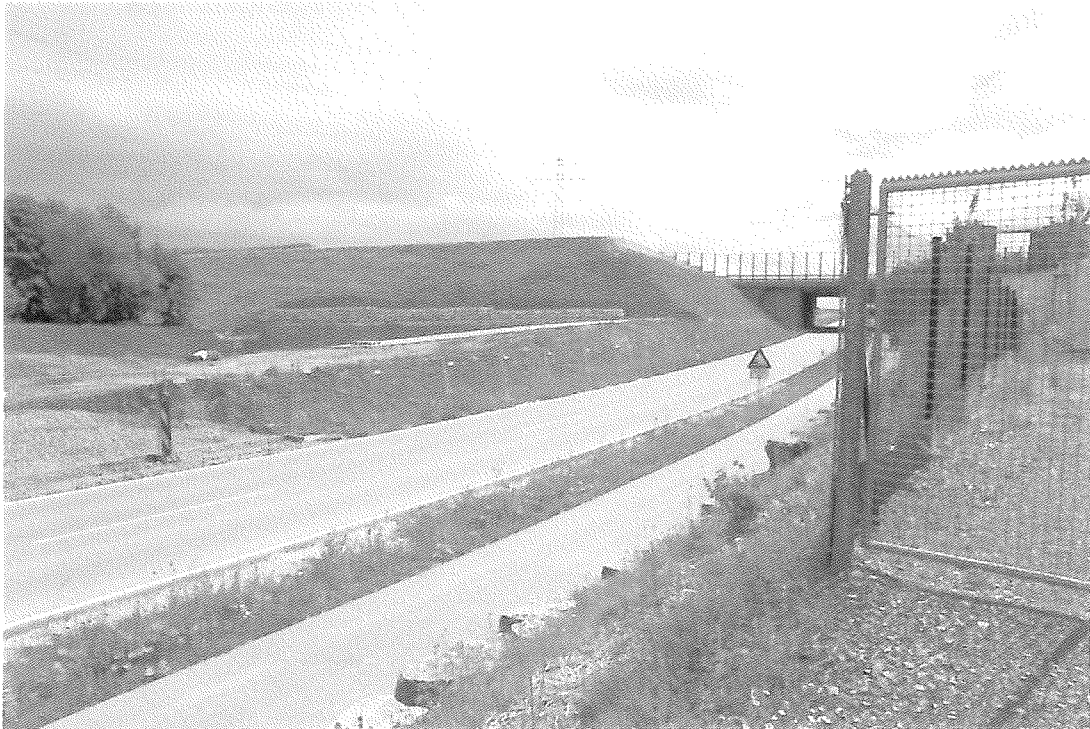
Bild A1-3: Blick nach Süden in Richtung der A 8 mit dem Lärmschutzwall und der Unterführung.
