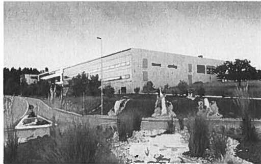
Abbildung 4: Bestandsgebäude Altatec Ansicht Nord, (Quelle: website Altatec GmbH, 05.01.2017)
