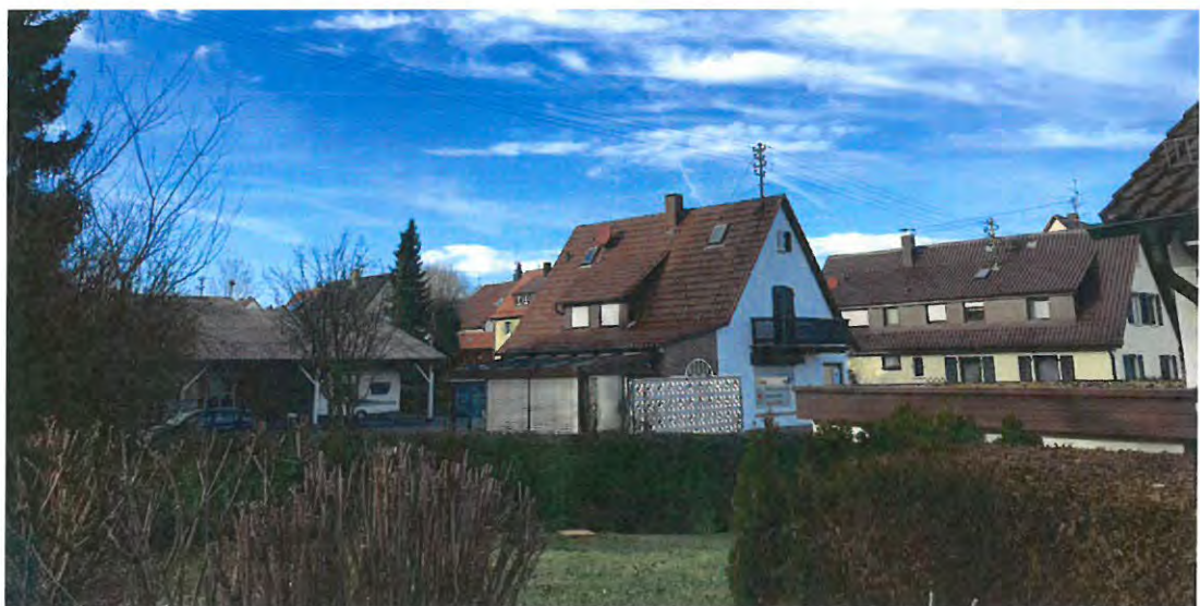
Abbildung 4: Plangebiet von Südosten (Pfadweg)
