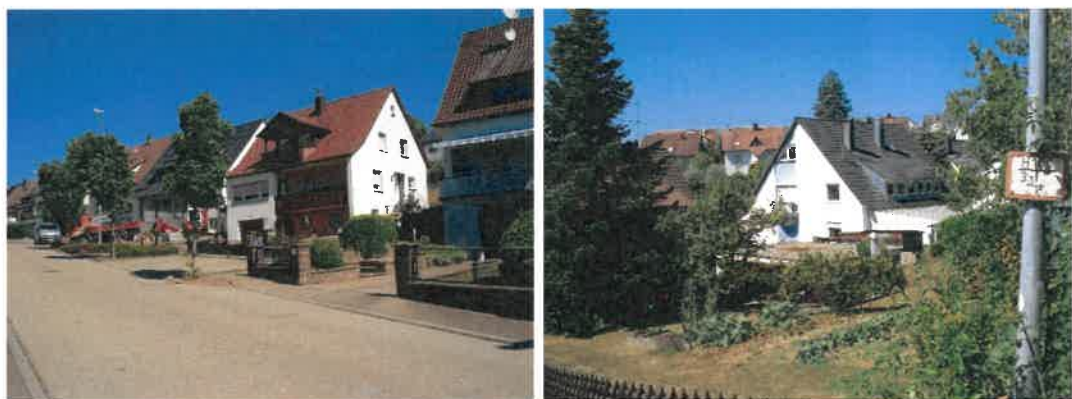
Abbildung 6: Fotos Plangebiet 2022 (links: Blick von Austräße auf Gebäude Austräße 32, rechts: Blick von Haselweg auf Gebäude Austräße 22)
