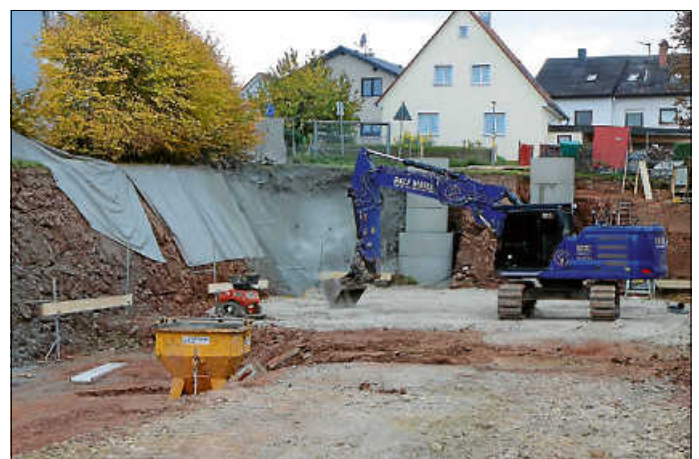
Blick in die Baugrube
