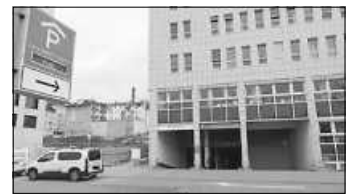
Ab 25. März nur noch für Dauerparker geöffnet: Die Tiefgarage im Landratsamt an der Güterstraße in Pforzheim.
