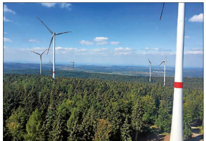
Blick über den Windpark Straubenhardt, wo elf Anlagen Strom produzieren.
