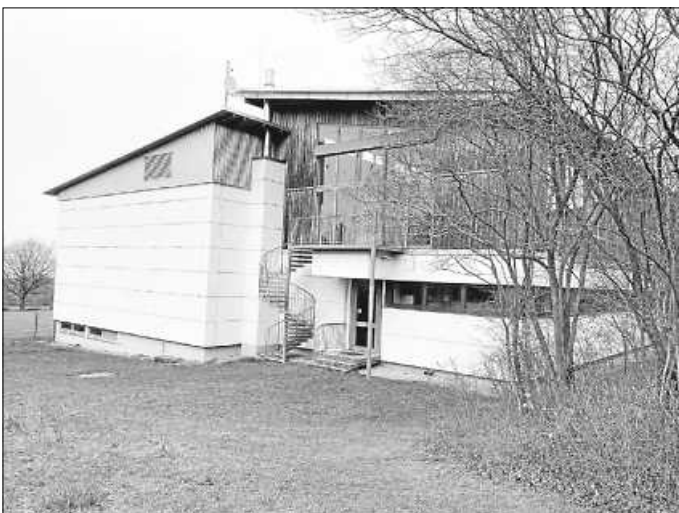
Vorbereitungen können starten für die Unterbringung von ukrainischen Flüchtlingen in der Halle in Schwann.
