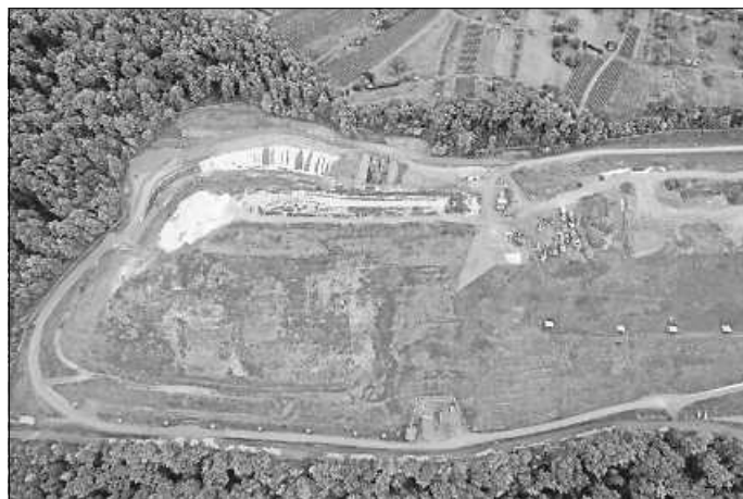
Die Deponie Hamberg in Maulbronn ist eine Deponie der Klasse DK II mit den gesetzlich vorgeschriebenen hohen Schutzmaßnahmen und -einrichtungen. Entsprechend wertvoll stuft der Enzkreis das noch im geringen Maße vorhandene Restvolumen ein. Foto: enz; Foto: Enzkreis
