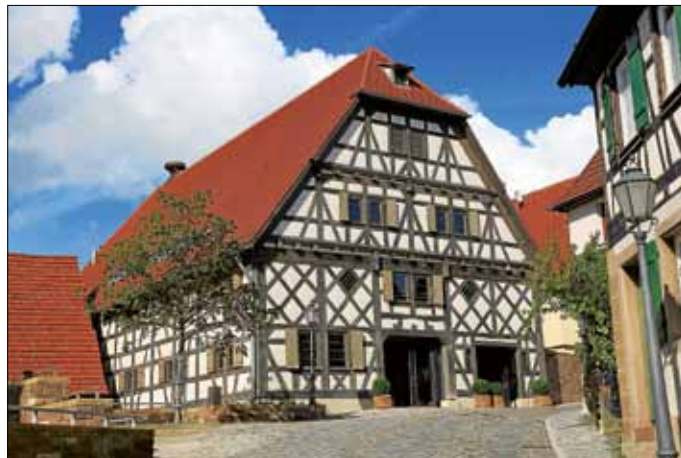
Die historische Kelter in Ötisheim öffnet am Sonntag, 9. September, beim Tag des offenen Denkmals die Türen für Interessierte. Geboten wird ein vielfältiges Rahmenprogramm rund um Erhalt und Sanierung von Denkmälern und Fachwerk.(enz)
